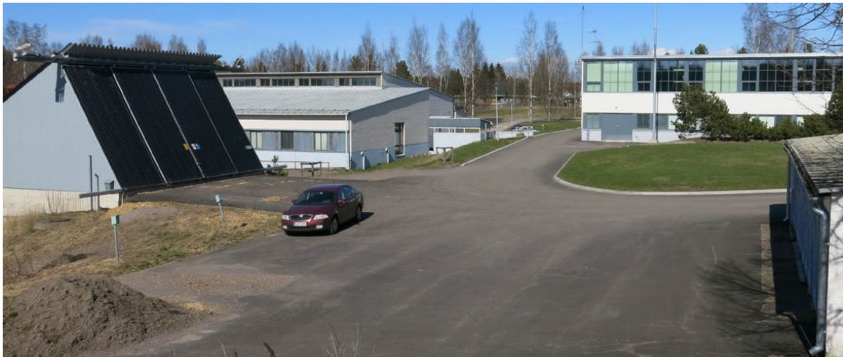
Kaduksi osoitettu Urapolku on tällä hetkellä rakennuspaikan sisäinen tie. Vasemmalla lämpökeskus ja sen takana ammatti-instituutin verstashalli 1980-luvulta
