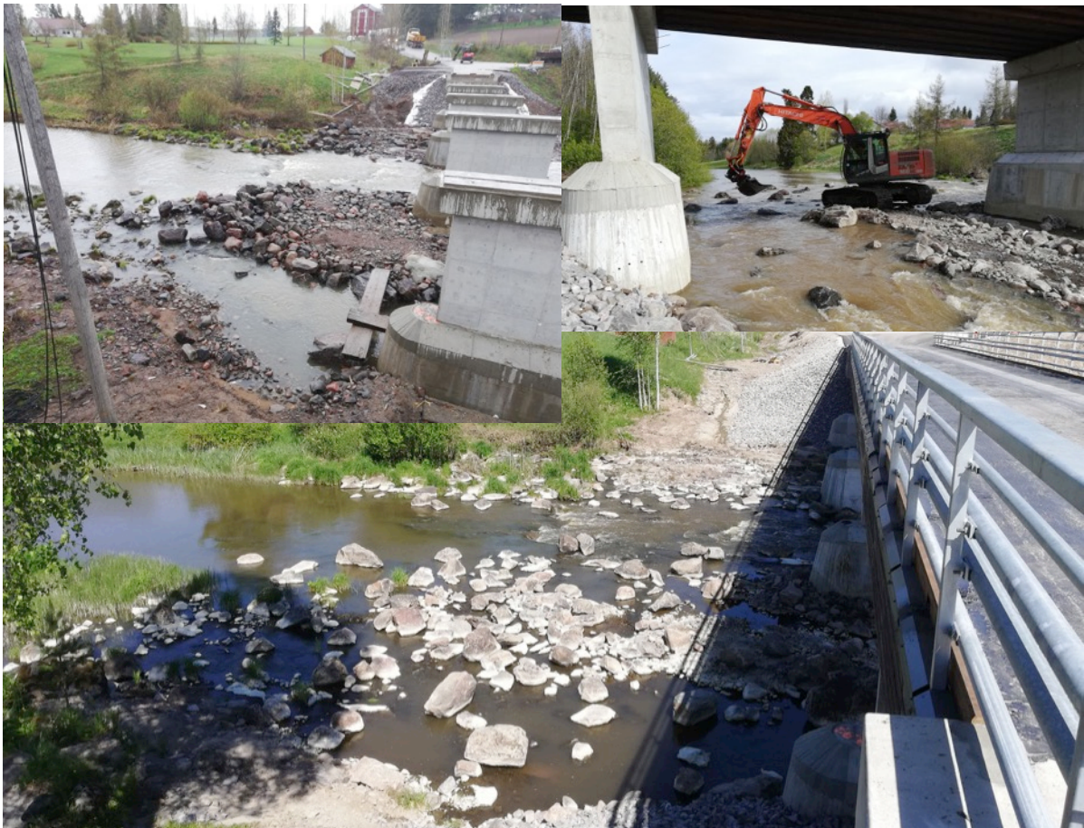
Kuva 6. Pukkilan Syvänojan kunnostustyömaa.
