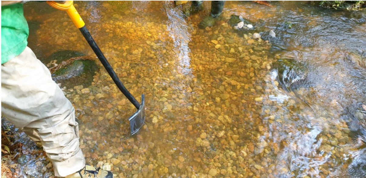
Kuva 8. Sipoonjoen Byabäckenillä kunnostettiin soraikoita lapiotyönä.
